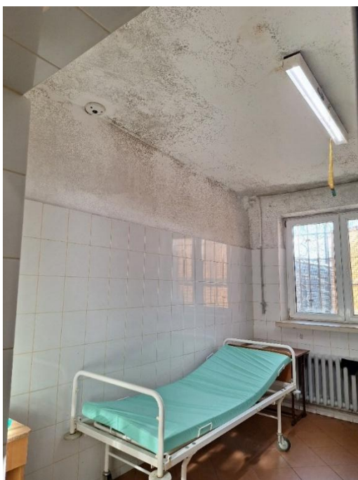
Zdj. 3. Wnętrze celi B-220.
