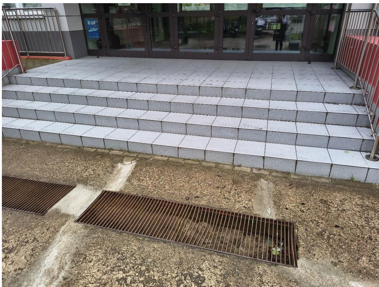
Zdjęcie 4: Schody bez oznaczonych krawędzi
