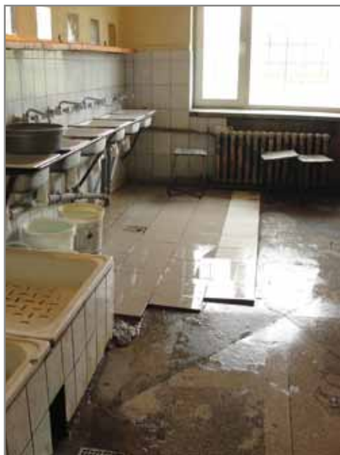
Sanitariaty w Zakładzie Karnym w Łupkowie
