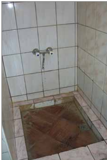
Sanitariat w Zakładzie Karnym w Uhercach Mineralnych
