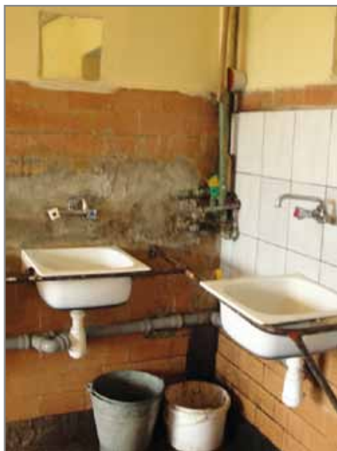
Sanitariaty w Zakładzie Karnym w Łupkowie
